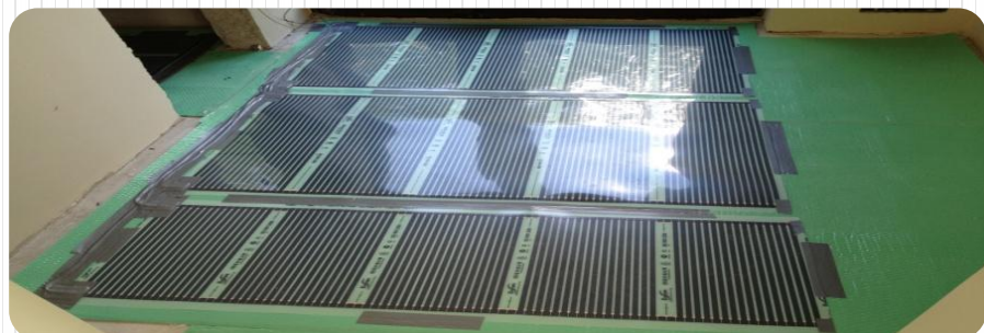
6. Szabadon maradt fűtőfilm végek szigetelése, rögzítése
