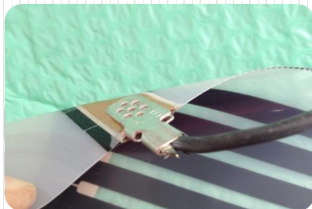
5. Elektromos csatlakozó csipesz rögzítése
