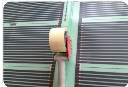
4. széles ragasztó szalaggal rögzítés a szigetelő felülethez
