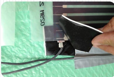
5. Elektromos csatlakozó csipesz szigetelése bitumenes szalaggal
