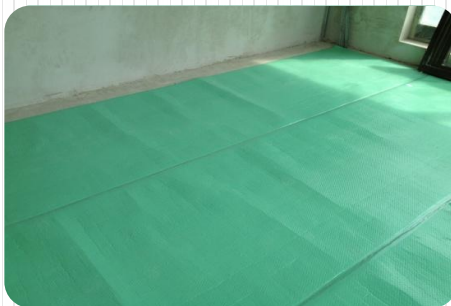
2. Szigetelés, hő tükrő beépítés
